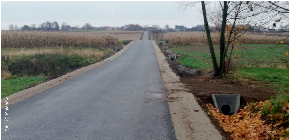
Odcinek nowo wybudowanej drogi
